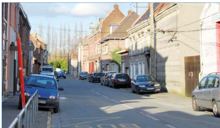
Les rues Lebas, Môquet, Anatole-France, Couturier et le chemin de la voie ferrée seront rénovés dans les prochains mois.
