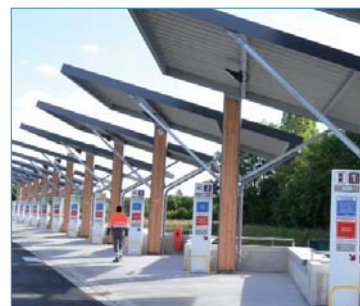
Le quai du haut avec la signalétique et les bennes protégées par des auvents.
