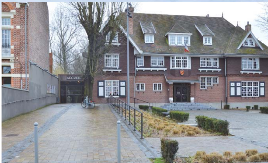
Une rampe d'accès permet aux personnes à mobilité réduite de se rendre à l'Hôtel de Ville depuis la voie publique. À l'intérieur du bâtiment, un ascenseur sera installé.
