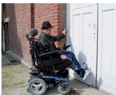
Pour accéder à salle des fêtes, lors des manifestations, une personne à mobilité réduite peut avertir de sa présence grâce à un interrupteur.
