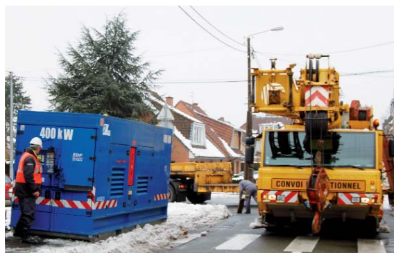
Les équipes d'ERDF ont été rapidement à pied d'oeuvre pour rétablir le courant avec des groupes électrogènes.
