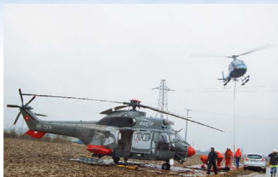
Deux hélicoptères ont fait la navette pour installer des pylônes provisoires afin de soutenir les câbles qui devaient être mis en service ce vendredi 9 mars.
