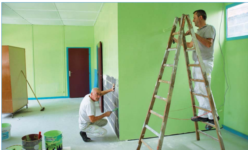
Les locaux de l'accueil périscolaire Langevin ont été refaits par les ateliers municipaux. Cela concerne notamment la peinture et la création de sanitaires.
