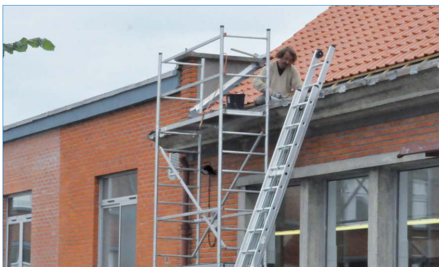
Réfection de la toiture au restaurant scolaire Paul-Langevin.
