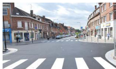
Le carrefour Hentgès/Carnot rénové.
